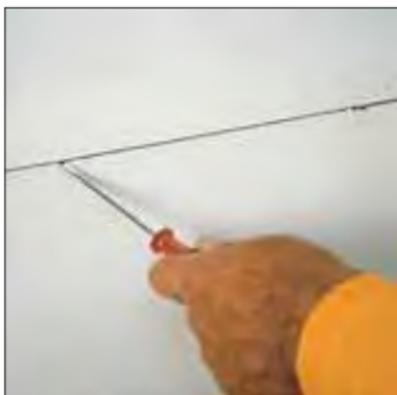
Compruebe todas las soldaduras de los solapes con un destornillador del nº 2.
