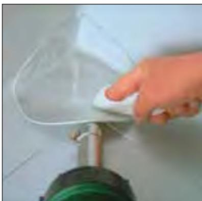
Suelde la superficie en contacto con la lámina horizontal.
