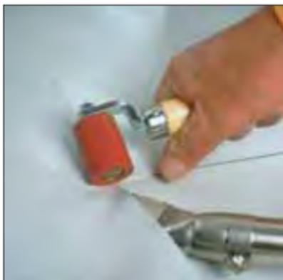
Tenga cuidado de soldar el escalón de las dos membranas anteriores, sin burbujas ni capilares.
