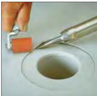
Suelva la membrana de cubierta a la parte plana del sumidero revestida con PVC.
