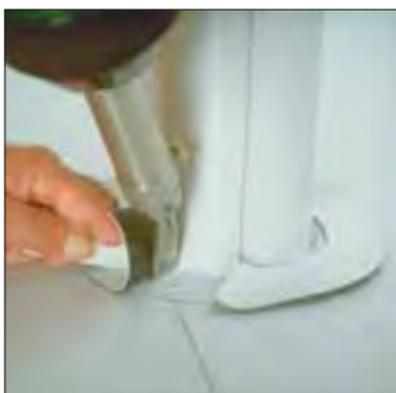
Suelde el anillo corrector Sikaplan® con la boquilla de 20 mm.
