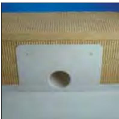
Coloque el aliviadero/desagüe y fíjelo con al menos cuatro tornillos. Por favor, fíjese en que le borde horizontal se coloca bajo la membrana de cubierta. Limpie la superficie a soldar.
