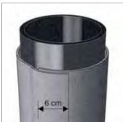
Mida y corte una pieza de membrana no reforzada. Hay que prever una longitud de solape sumándola a la longitud de la circunferencia (6 cm).
