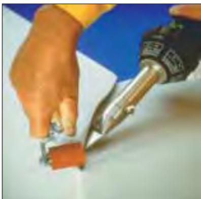
Suelva el pliegue sobre la membrana de cubierta. Empiece por la esquina y continúe hacia afuera.
