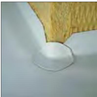
Durante el proceso de aplicación tiene que evitar que el agua penetre entre las capas de la cubierta. Suba hacia arriba la membrana a 5 cm y suelde la esquina con un parche ovalado.
