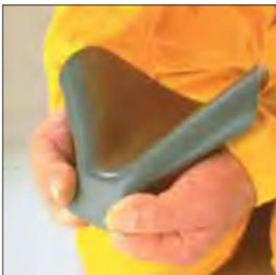
Corte una pieza redonda de membrana sin reforzar: El diámetro tiene que ser suficientemente grande como para cubrir ambas capas solapadas al menos 30 mm. Caliente y estire la pieza hasta darle la forma deseada. Puede utilizar piezas prefabricadas y se ahorrará el tiempo del preparación.
