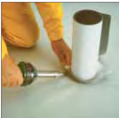
Suelde las partes de conexión estiradas sin adhesivo. Utilice la boquilla de 20 mm. Empiece con la superficie de conexión inferior de atrás hacia delante. Protéjase los dedos con un trapo húmedo.
