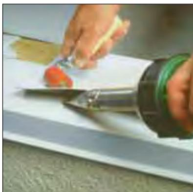
Como los perfiles metálicos transmiten mucho calor, el soldado se debe hacer en dos fases:
