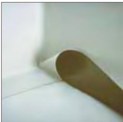
Suelde la tira **Sikaplan**<sup>®</sup> completamente sobre la membrana de la cubierta.
