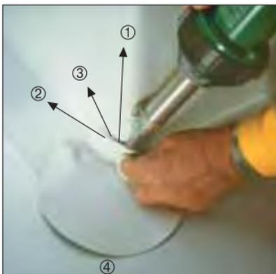
Achaflane con aire caliente y rodillo el escalón de láminas que queda en el solape. Suelde la esquinera que ha hecho desde dentro hacia fuera para evitar las arrugas. Utilice la boquilla de 20 mm.
