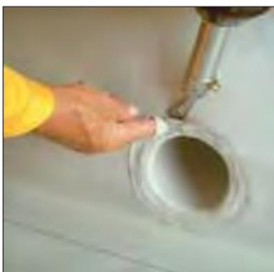
Coloque el tubo hecho con **Sikaplan®** y suéldelo a la membrana de impermeabilización de la cubierta.
