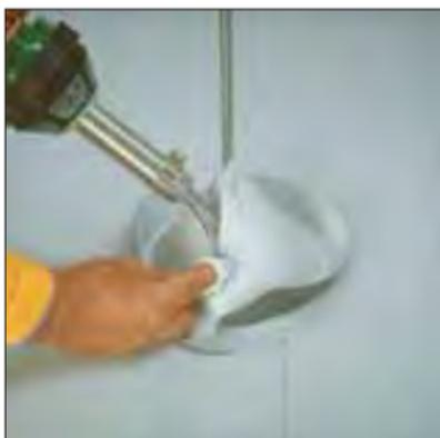
Suelde la pieza a la membrana de de la cubierta y sobre si misma en vertical. Utilice la boquilla de 20 mm.
