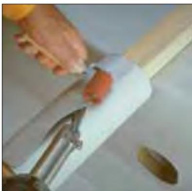
Suelde el tubo en la parte exterior.
