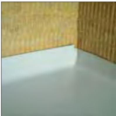
Durante la aplicación evite que el agua penetre entre las capas de la cubierta. Coloque la membrana sobre el peto 5 cm en posición vertical. Doble el rincón en posición vertical y suelde la parte plegada.
