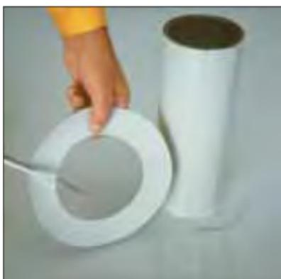
Si ve quemaduras, ampollas u otros fallos de soldado aplique un anillo corrector encima. Del mismo modo puede reforzar las soldaduras mal hechas, mediant parches. El diámetro interior de dicho anillo corrector tiene que ser 1.5 cm mayor que el diámetro exterior del tubo.
