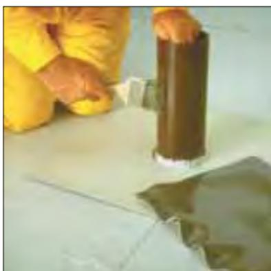
Aplique adhesivo al tubo y preparar la pieza para cubrir la tubería.
