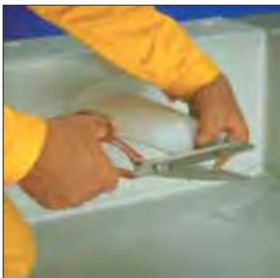
Corte una pieza rectangular de membrana no reforzada; debe ser tan ancha como el peto. Haga un corte en las esquinas a 45°.
