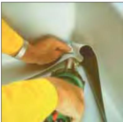
Fije el borde de la tira **Sikaplan®** sobre la membrana horizontal a todo lo largo del perímetro y sueldelo doblando correctamente la parte del rincón.
