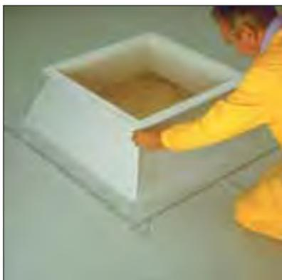
Adhiera la membrana vertical al soporte. Suelde la parte inferior sobre la membrana de cubierta.
