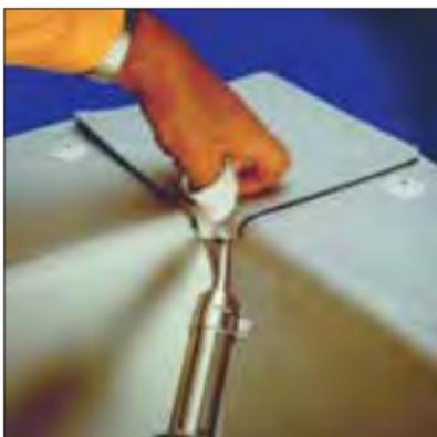
Suelde la parte prefabricada completamente sobre la esquina. Utilice una boquilla de 20 mm.
