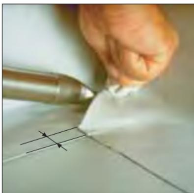
Suelde el pliegue a la membrana de la cubierta. Empiece por el rincón.
