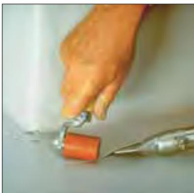
Suelde ambas partes solapadas por completo sobre la membrana de cubierta.
