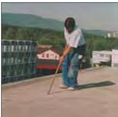
**Corte la membrana de impermeabilización** en tiras de 1 m de ancho, usando un cutter. Para mantener una posición de trabajo lo más vertical posible, fijar la herramienta cortante a un palo.
