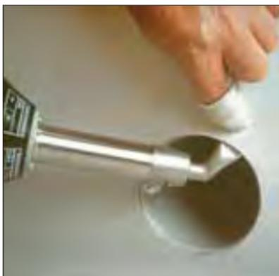
Cortar una pieza de lámina sin armar con la forma de la salida frontal
