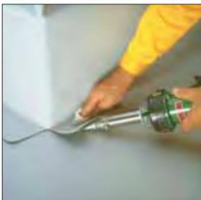
Cubra el peto con una tira de lámina y fijela soldándola al borde de la impermeabilización principal. Recuerde: El ancho del solapado sobre la superficie de cubierta tiene que ser al menos de 12 cm para pasar por encima de la fijación mecánica (ver capítulo 4.14).
