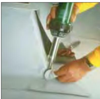
Suelde las piezas con la membrana de cubierta; separando los cortes de las esquinas. Suelde un parche redondo de membrana no reforzada a cada esquina (diámetro 5 cm).
