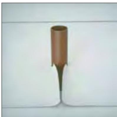
Corte la membrana de cubierta perpendicular al borde hasta el tubo de ventilación y corte el hueco que ocupa en su base.
