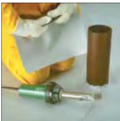
Caliente y estire la tira. Esto no es necesario si utiliza un tubo de conexión prefabricado **Sikaplan®**
