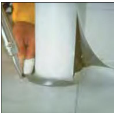
Sujete el soldador de mano en posición vertical para la última parte de la soldadura; esto evitará quemaduras.
