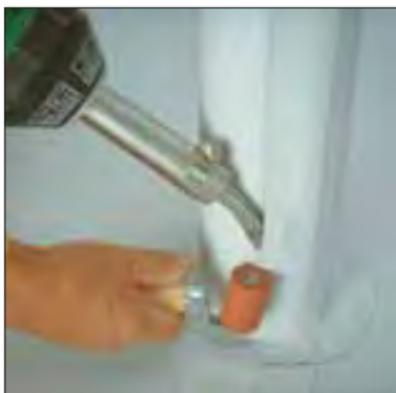
Suelde el solapado vertical de abajo hacia arriba. Utilice la boquilla de 20 mm.
