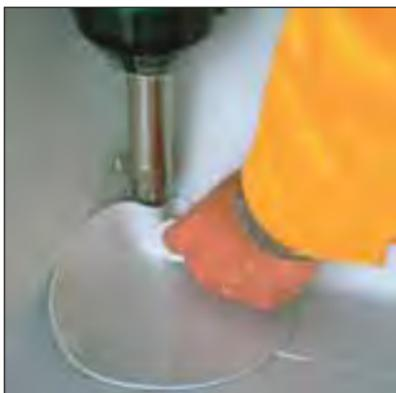
Primero suelde la pieza prefabricada en la esquina.
