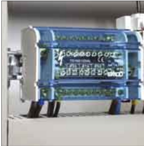
Bloque repartidor montado sobre raíl DIN
