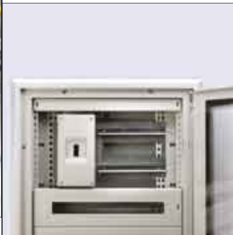
Colocación de ICP de 63A con tapa de protección de 2 filas y capacidad de 30 módulos en superficie y 26 módulos en empotrar
