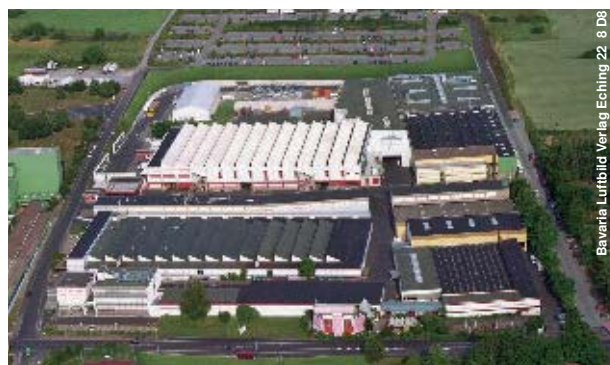
Vista aérea de WAREMA, Marktheidenfeld
