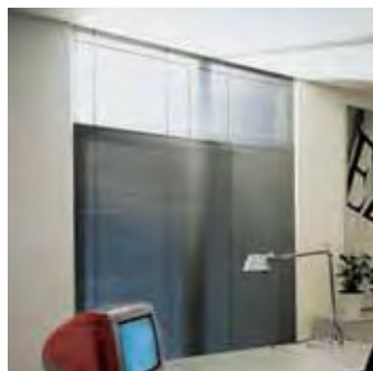
Persianas deflectoras de luz con láminas reflectoras reflejan la luz contra el techo. El ambiente se ilumina uniformemente y sin deslumbrar.
