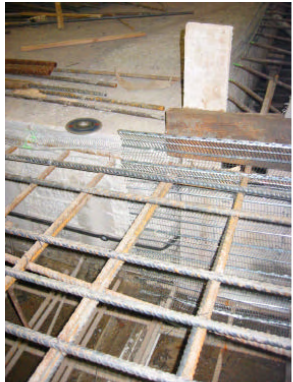
Fotografía núm. 3. ADEKA KMU 2010 sobre una junta de trabajo (esquina) (II).
