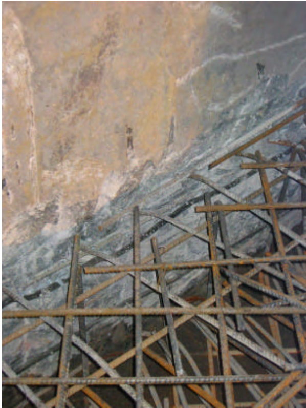
Fotografía núm. 1. Doble cordón de perfil hidroexpansivo ADEKA KMU 2010.
