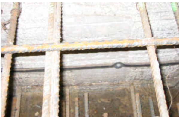
Fotografía núm. 2. ADEKA KMU 2010 sobre una junta de trabajo (I).
