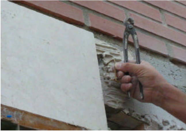
Fotografía núm. 5. Colocación anclaje mecánico (I).
