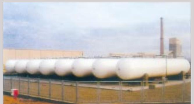
Instalaciones en una fábrica de vidrio de 8 depósitos de 207 m³
