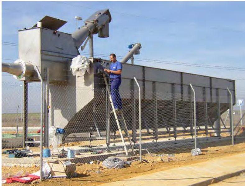
TSF 3/100 para el pretratamiento de la aguas residuales de un polígono industrial
