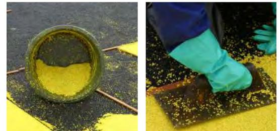
Los materiales que se usan para instalar el pavimento continuo son goma EPDM en colores, goma SBR negra y resinas especiales.
