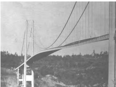
El puente oscilando por la acción del viento
