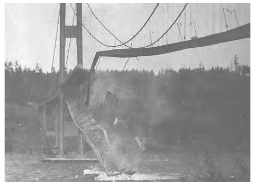
Fallo del puente al entrar en resonancia
