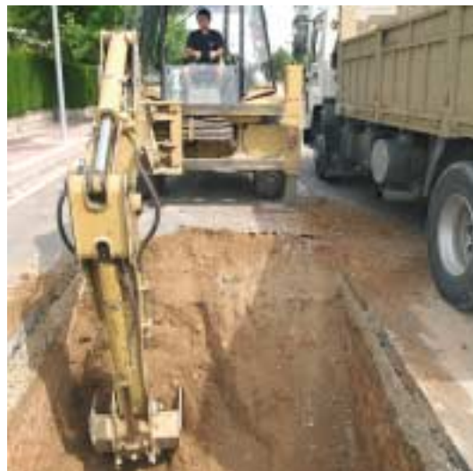
1. Excavación de foso
