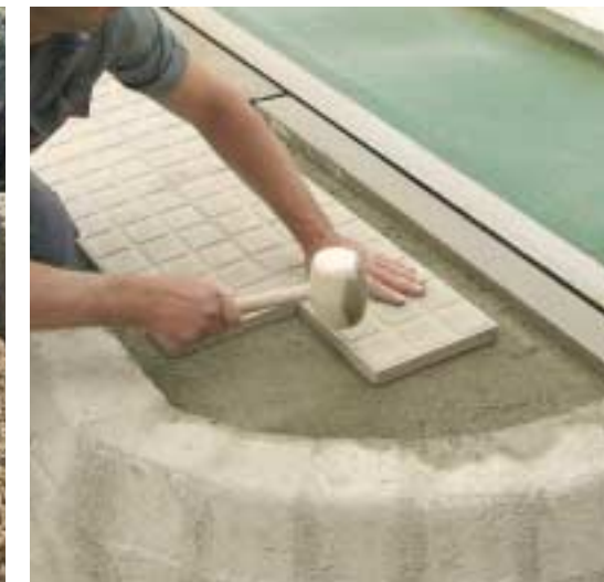
6. Colocación de pavimento
