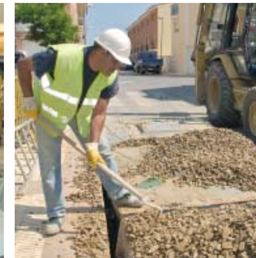
5. Relleno de grava entre foso y arqueta
