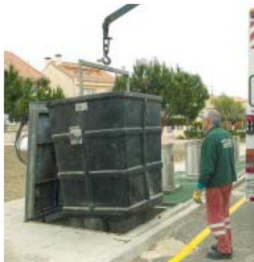
2. Extracción del contenedor de la arqueta.
