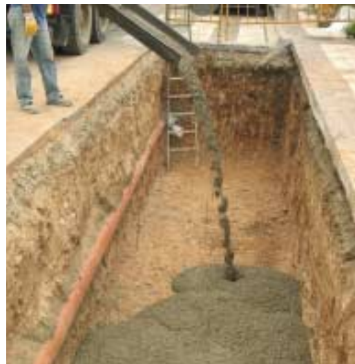
2. Solera de hormigón
