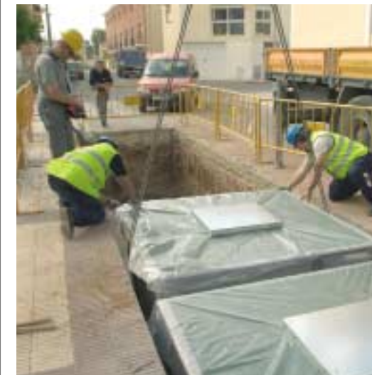
4. Colocación de arquetas
