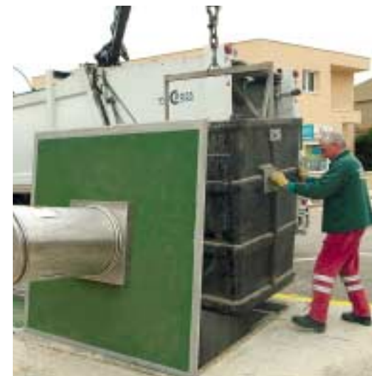
4. Introducción del contenedor en la arqueta.
