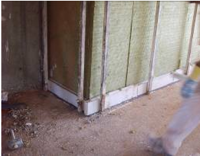
Construcción 2ª hoja
