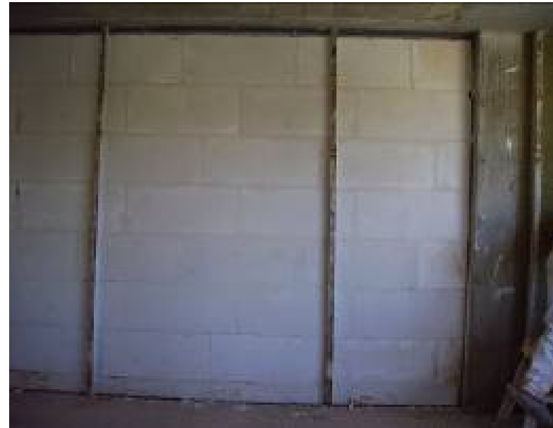
Pared separadora acabada
