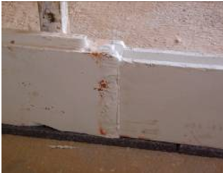
Colocación de las bandas en la base de la pared
