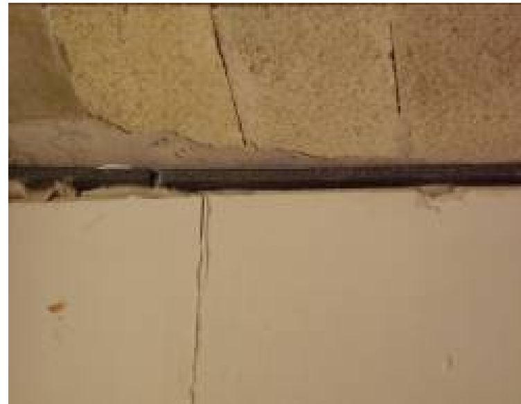
Colocación de las bandas en la cima de la pared
