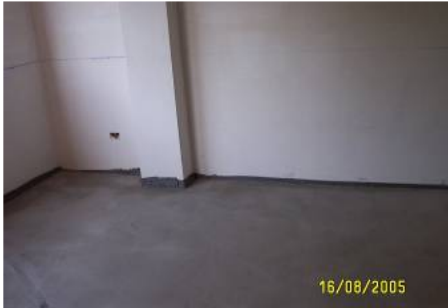
Solado correctamente ejecutado (la lámina sube sobre el tabique en todo el perímetro)
