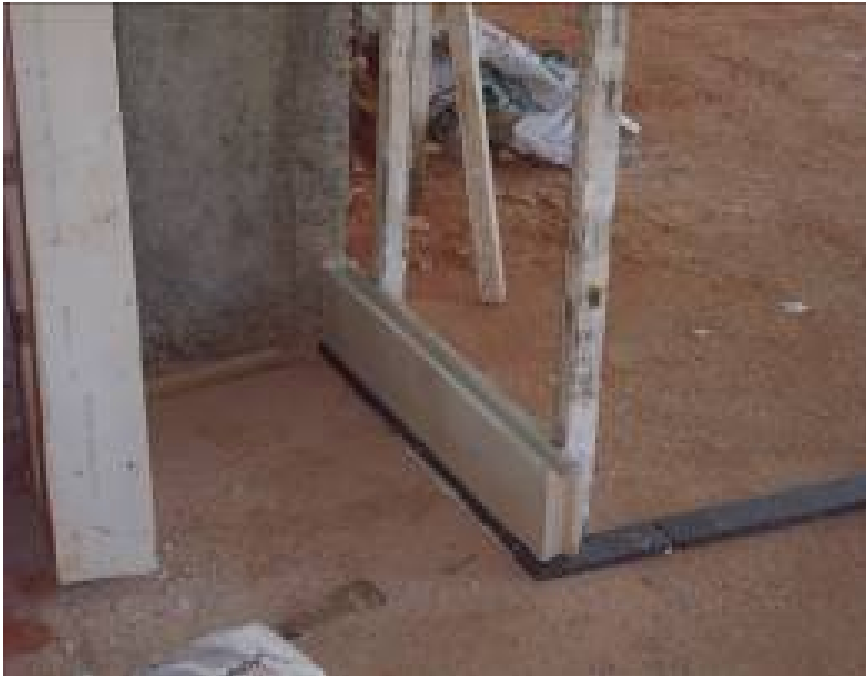
Encuentro con la caja de ascensor
