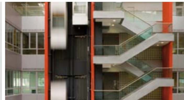
MP GLASS lift Edificio Bluenet Sevilla. España. Ascensor: MP Murano 610V "C"
