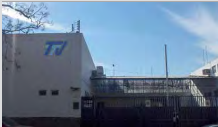
FABRICA TTV MÉXICO TTV PLANT MEXICO TTV- WERK MEXIKO
