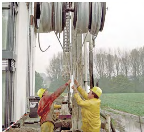
Instalación de una sonda geotérmica RAUGEO
