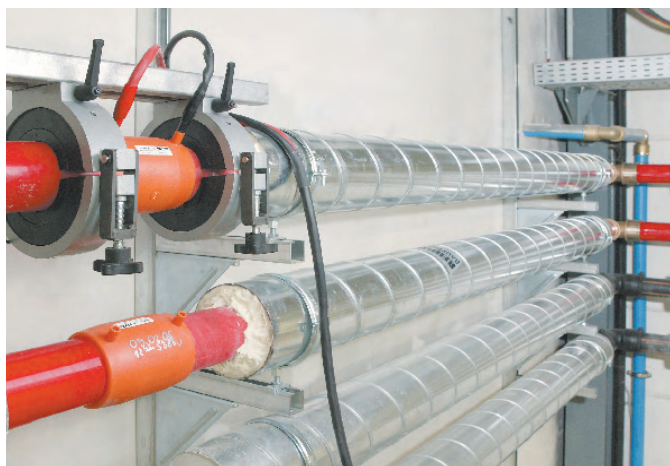
Fig. 46: Realización de la unión con alineador de tubo universal
