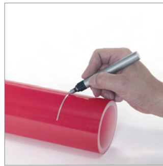
Fig. 29: Para el marcado utilizar rotulador de un color que contraste con el del tubo.
