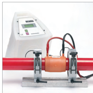
Fig. 32: Soldar los extremos de los tubos poco después de rasparlos.
