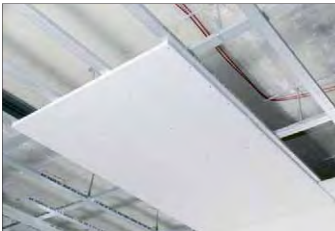
Fig. 8-5 Elemento de techo montado
