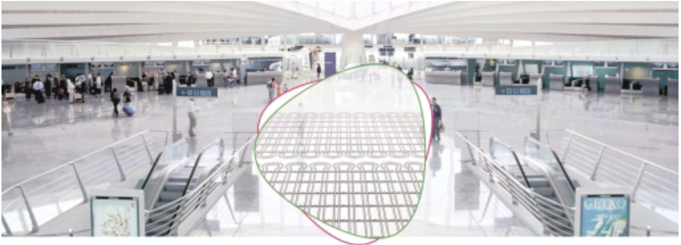
Calefacción/refrescamiento por superficies radiantes de REHAU en el aeropuerto de Bilbao
