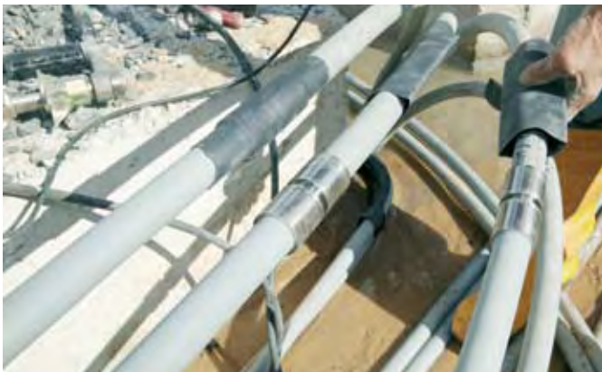
Fig. 54: Empalme con las tuberías de conexión
