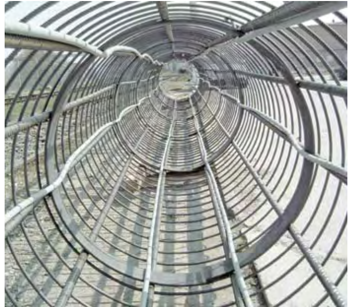
Fig. 15: Tubo RAUGEO collect PE-Xa montado en una jaula de armadura
