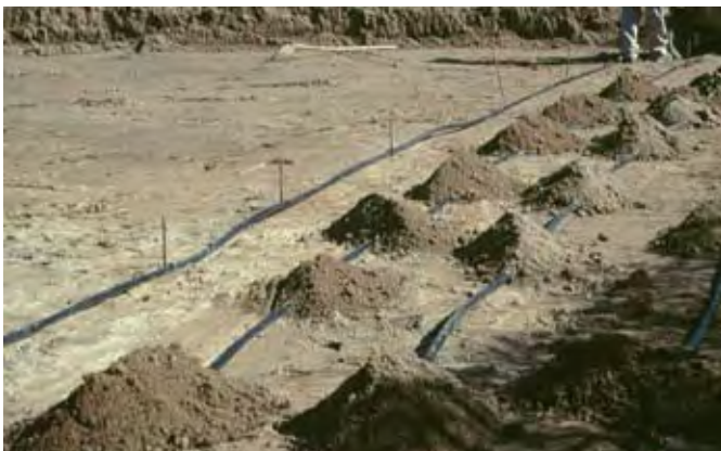
Fig. 47: Cobertura de los tubos con suelo excavado o arena
