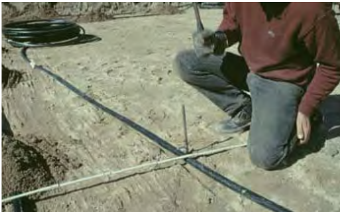
Fig. 46: Extensión y fijación del tubo
