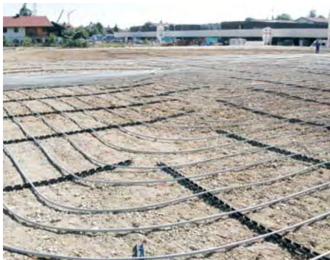
Fig. 10: Colocación del tubo RAUGEO collect PE-Xa
