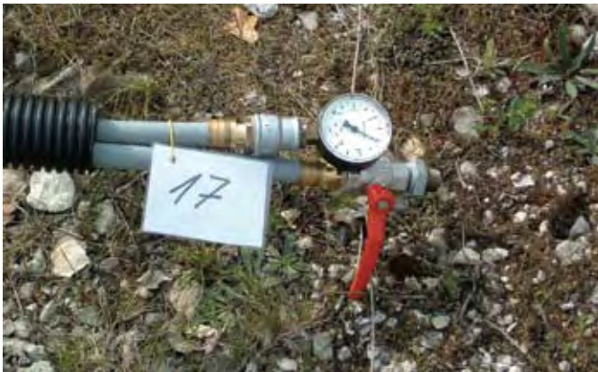
Fig. 60: Montaje de la unidad para pruebas de presión
