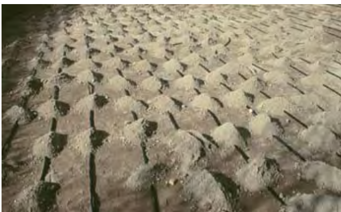
Fig.48: Llenado y cobertura de los tubos
