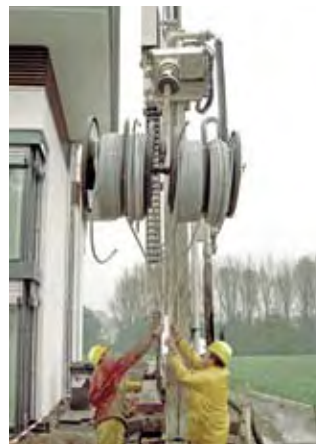
Fig. 4: Introducción de una sonda RAUGEO PE-Xa
