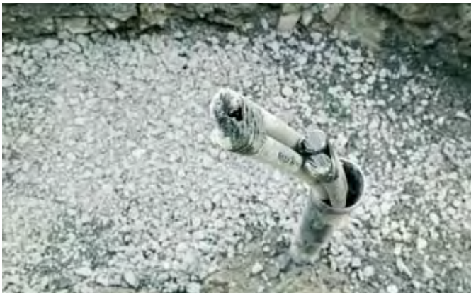
Fig. 53: Rellenado del pozo
