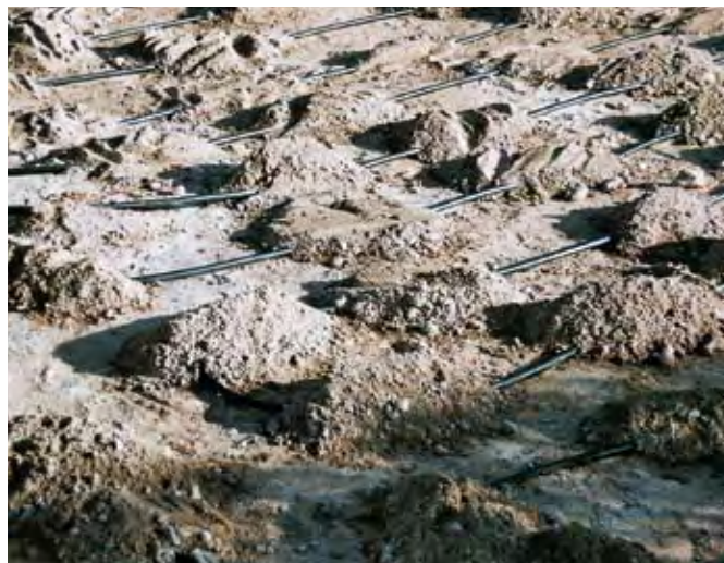
Fig. 12: Colocación del tubo RAUGEO collect PE-100
