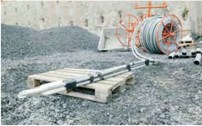
Fig. 51: Inspección y preparación de la sonda
