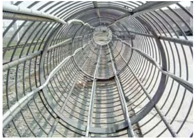
Fig. 55: Tendido del tubo dentro de un pilote energético
