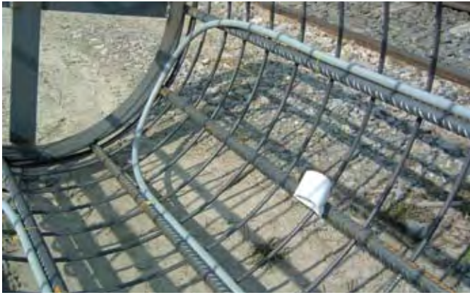
Fig. 58: Montaje de las tuberías en la jaula de armadura
