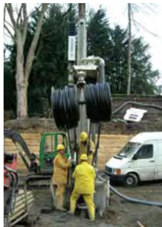
Fig. 7: Introducción de una sonda RAUGEO PE 100
