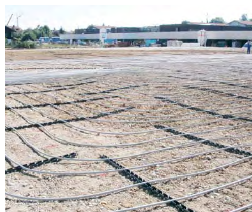
Colocación de los colectores geotérmicos RAUGEO
