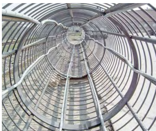
Pilote energético antes de la colocación
