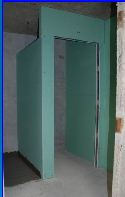
Colocación Interior de Pladur
