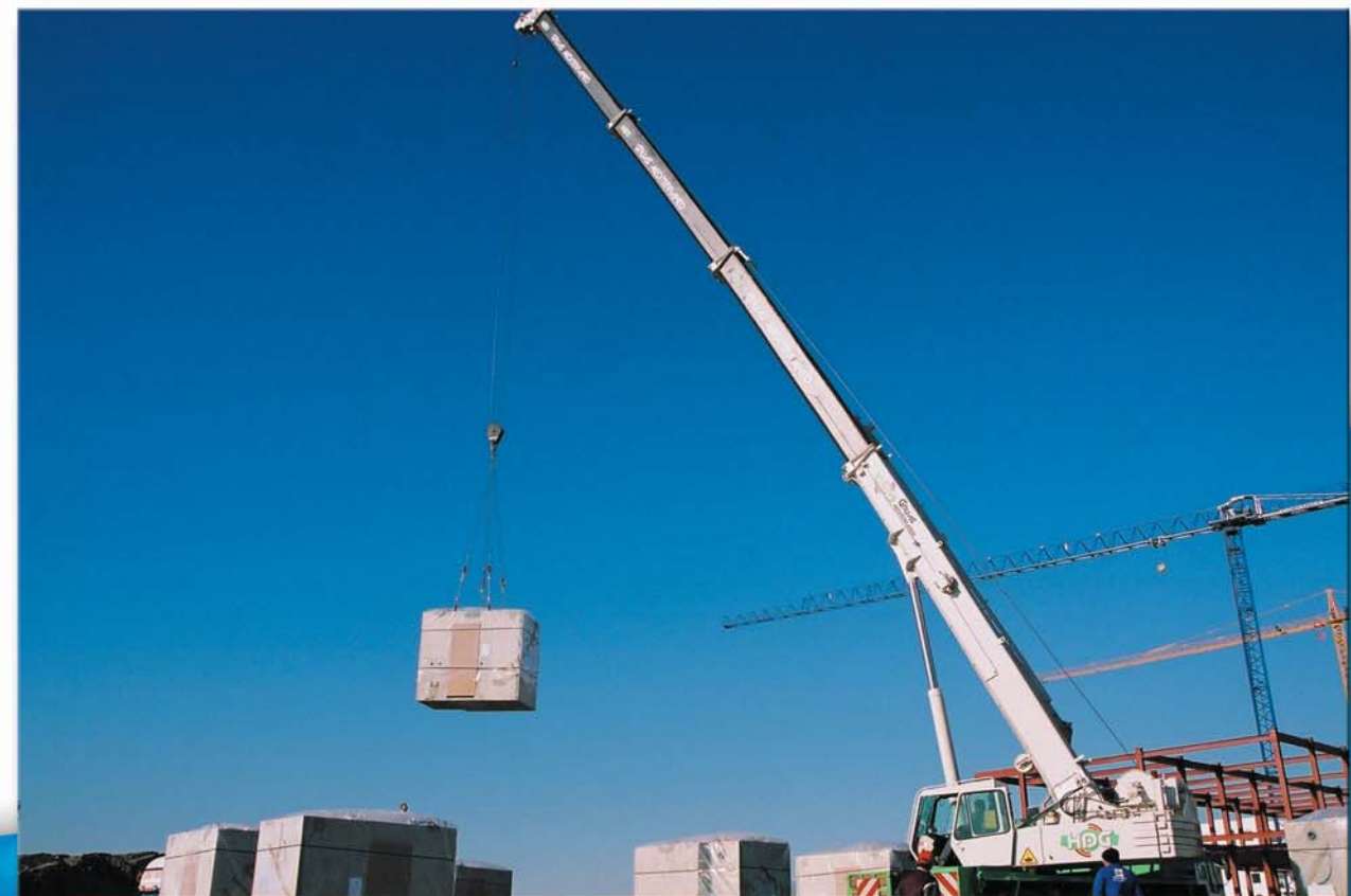
Descarga de camión con grúa de obra Unloading with works crane
