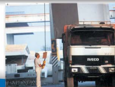
Descarga de camión con autogrúa Unloading with vehicle mounted crane
