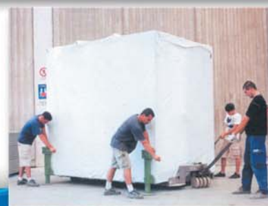
Desplazamiento de la célula de baño Moving of bathroom cell
