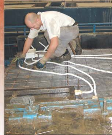
Preinstalación eléctrica Electrical pre-installation
