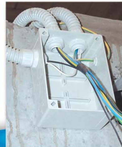
Caja de derivación estanca Sealed distribution box
