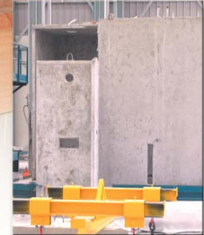
Montaje de Célula de baño Bath Unit installation
