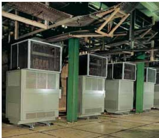
Transformadores **Trihal** instalados en una fábrica siderúrgica.
