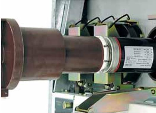
Detalle del cierre de seguridad del portafusibles.
