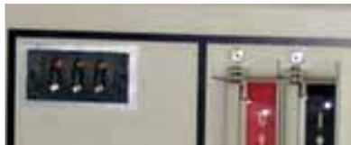
Dispositivo con bloque de 3 lámparas de presencia de tensión (VPIS).
