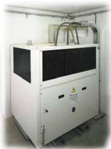
Conexiones BT mediante CEP en IP00.
