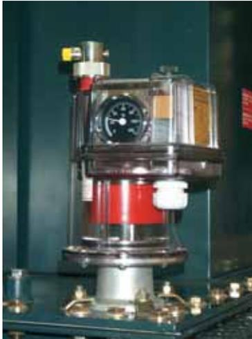
La seguridad del transformador está garantizada con un relé que integra las siguientes funciones de protección:
