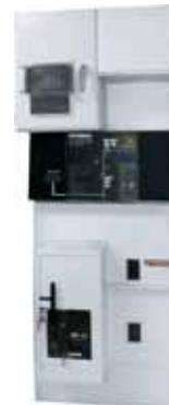
Celda de interruptor automático con relé Sepam.
