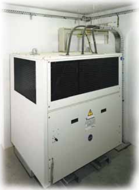
Conexiones BT mediante CEP en IP00.
