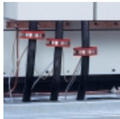
Toroidales detección de paso de falta.
