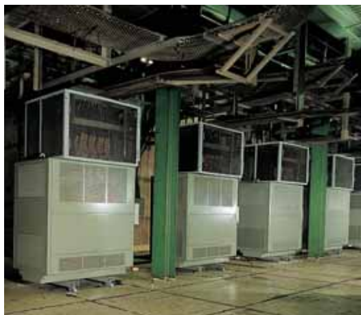
Transformadores Trihal instalados en una fábrica siderúrgica.
