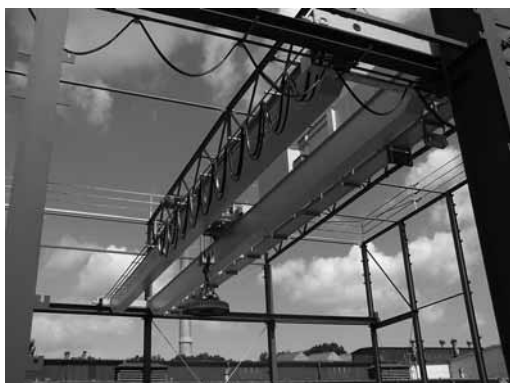
Aplicación de grúa
