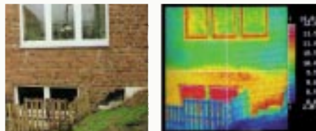
Figura 7: Termografía de la fachada
