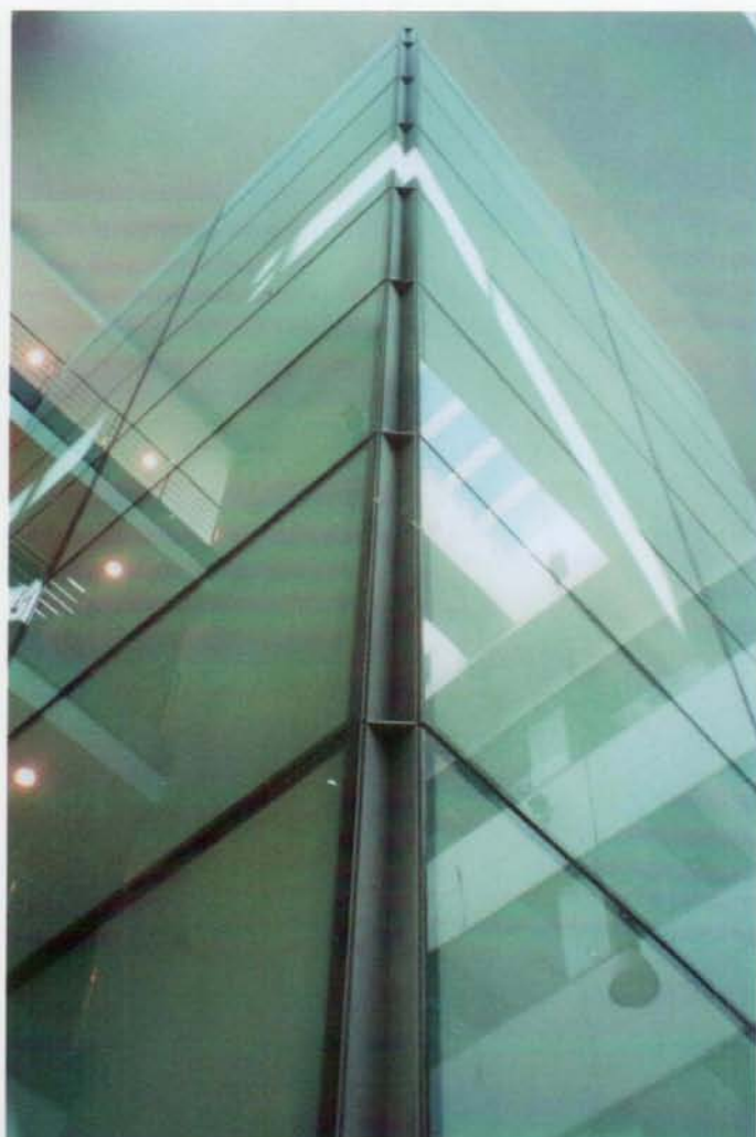
■ EDIFICIO OFICINAS BUSINESS MONTAÑA - LAS ROZAS (MADRID) FERROVIAL AGROMAN ARQ°.: TALLER DE IDEAS, S.L.
