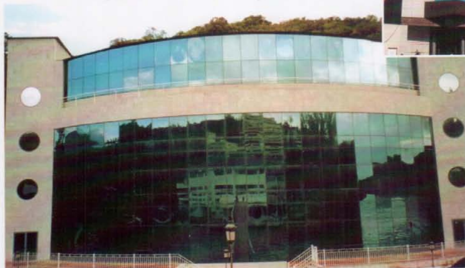
■ COMPLEJO RESIDENCIAL LOS ANGELES DE SAN RAFAEL - SEGOVIA NAYADE, S.L. ARQº.: D. EUGENIO SANCHEZ MORO
