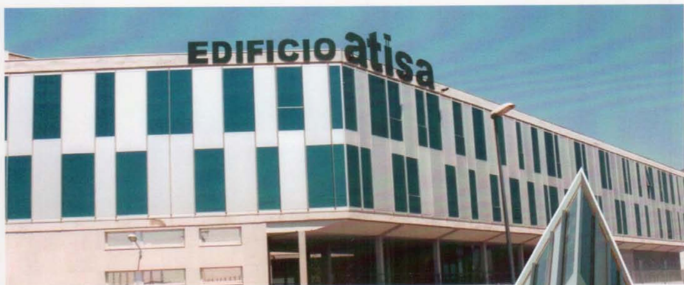
■ EDIFICIO ATISA - TORREJON DE ARDOZ (MADRID) ARQº.: D. ANTONIO RUIZ BARBARIN
