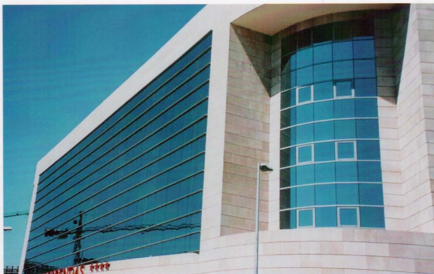
■ HOTEL AMURA - ALCOBENDAS (MADRID) TILMON ESPAÑA, S.A. ARQ°.: D.AMBROSIO ARROYO / D. JERONIMO ARROYO
