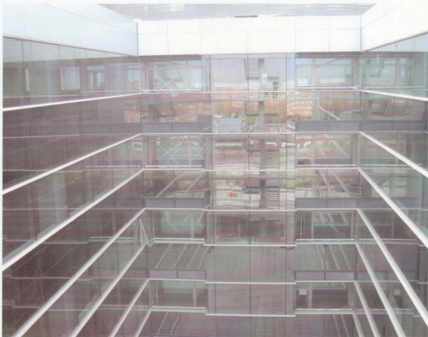
■ SEDE SOCIAL SIEMENS - TRES CANTOS (MADRID) CONSTRUCTORA SAN JOSE, S.A. ARQº: D. JULIO TOUZA - INGENIERIA: MACE
