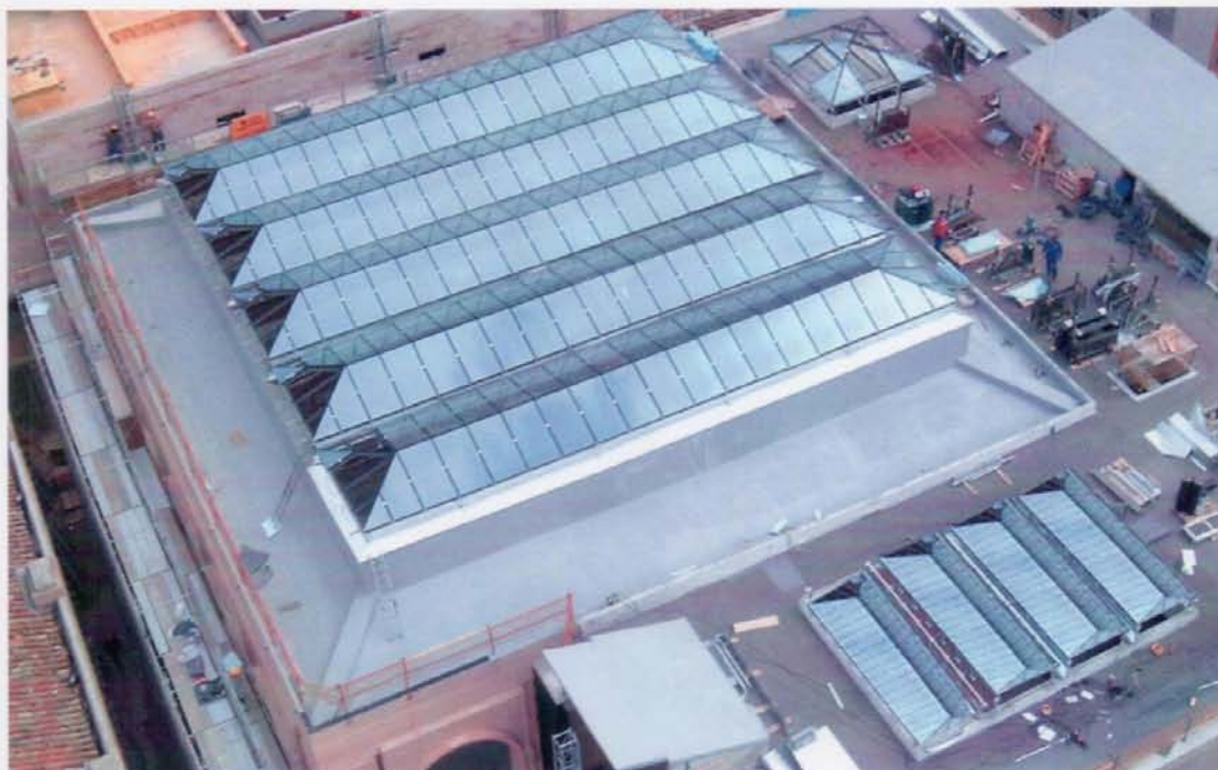
CLAUSTRO DE LOS JERONIMOS - MUSEO DEL PRADO - MADRID U.T.E.: ACS - CONSTRUCTORA SAN JOSE ARQ°.: D. RAFAEL MONEO
