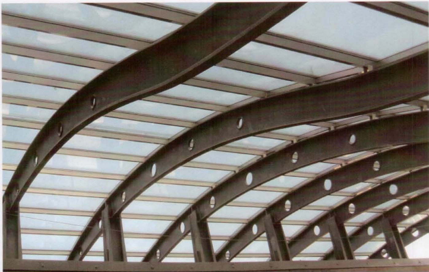
■ HOTEL URBAN - CARRERA DE SAN JERONIMO - MADRID CONSTRUCTORA SAN JOSE, S.A. ARQº: D. CARLOS BASO
