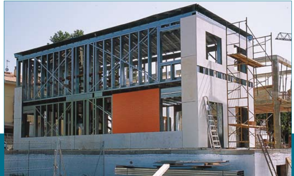
VIVIENDA DE ESTRUCTURA Y SUB-ESTRUCTURA DE ACERO LIGERO GALVANIZADO.
