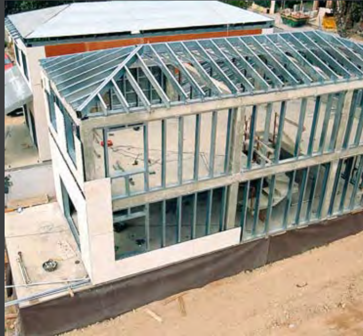
Biblioteca Blanquerna en Barcelona: estructura de acero pesado y subestructura de acero ligero.
