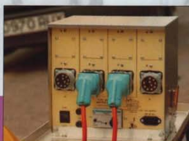
Conexión de líneas telefónicas
