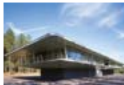
Centro de control del tráfico VCNON, Wolfheze, NL De Architecten Cie, Amsterdam Verkoelen Dakbedekkingen BV, Beegden TECU® Zinn
