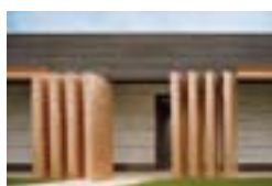
Cimitero Trescore, I Ing. Augusto Zambelli, Trescore Balneario (BG); Arch. Basilia Barcella, Bergamo EFFEGI Costruzioni S.r.l., Castelli Calepio (BG) TECU® Bronze
