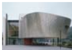
Haus am Fluss, DGF Stoess AG, Eberbach/Neckar, D Dipl.-Ing. Günter Hermann, Stuttgart Güther GmbH, Feuchtwangen TECU® Zinn
