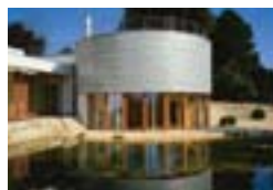
Casa particular, Herrliberg, CH R. Baenziger, Zurich Hersperger, Meilen (fachadas); Studer AG, Volketswil (fontanería) TECU® Zinn
