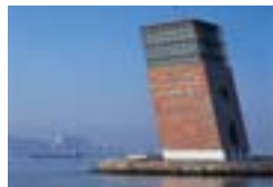
Torre de control del puerto, Lisboa, P Gonçalo Byrne, G.B. Arquitectos, Lisboa Zn-Revestimentos de Zinco Lda., Maia TECU® Classic
