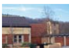
Casa particular, Nuremberg, D Haid+Partner Architekten+Ingenieure, Nuremberg Schlosserei Spenglerei StraBl, Arnstorf TECU® Bond
