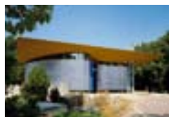
St. Maria der Engelen, Rotterdam, NL Mecanoo architecten, Delft Leidekkersbedrijf Jobse BV, Middelburg TECU® Zinn
