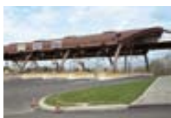
Estación de peaje, Lucca, I Büro Ettore Piras, Génova Trenkwalder S.r.l., Ovada (AL) TECU® Oxid
