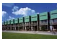
Edificio residencial, Purmerend, NL Roy Gelders Architecten, Amsterdam Ridder Dak-en Wandsystemen BV, Hoorn TECU® Patina
