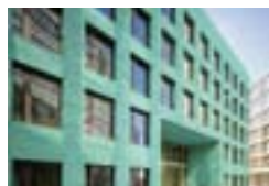
Casa de oficinas y comercio KAI 13, Düsseldorf, D Döring Dahmen Joeressen Architekten, Düsseldorf Zitzen GmbH, Mönchengladbach TECU® Patina
