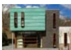
Casa particular, NL Charles Slot Bureau Ruimtelijke Vormgeving, Bergen PBK Technische Installaties BV, Alkmaar TECU® Patina
