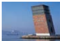
Torre de control del puerto, Lisboa, P Gonçalo Byrne, G.B. Arquitectos, Lisboa Zn-Revestimentos de Zinco Lda., Maia TECU® Classic
