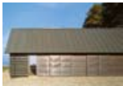
Casa de barquero, Fænø Gods, Middelfart, DK Schmidt, Hammer & Lassen A/S, Aarhus Eddie Clement A/S, Ejby TECU® Oxid
