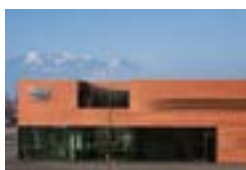
Casa de oficinas y comercio, Koblach, A AIX Architects, Feldkirch Peter GesMBH + CoKG, Koblach TECU® Classic
