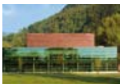
Edificio de producción y de oficinas Elektro Graf, Dornbirn, A Baumschlager & Eberle, Lochau Güther GmbH, Feuchtwangen, D TECU® Oxid
