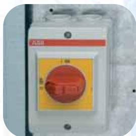
Interruptor paro-marcha montado de serie
