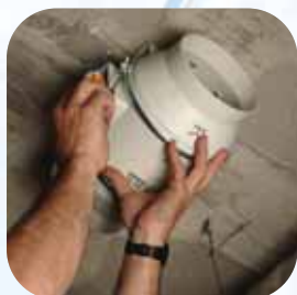
Colocar el cuerpo motor
