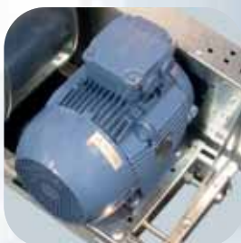
Motor estándar montado sobre bancada antivibratoria
