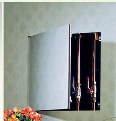
Trampilla de placa integrada en pared. Alcapão de placa integrada em parede.
