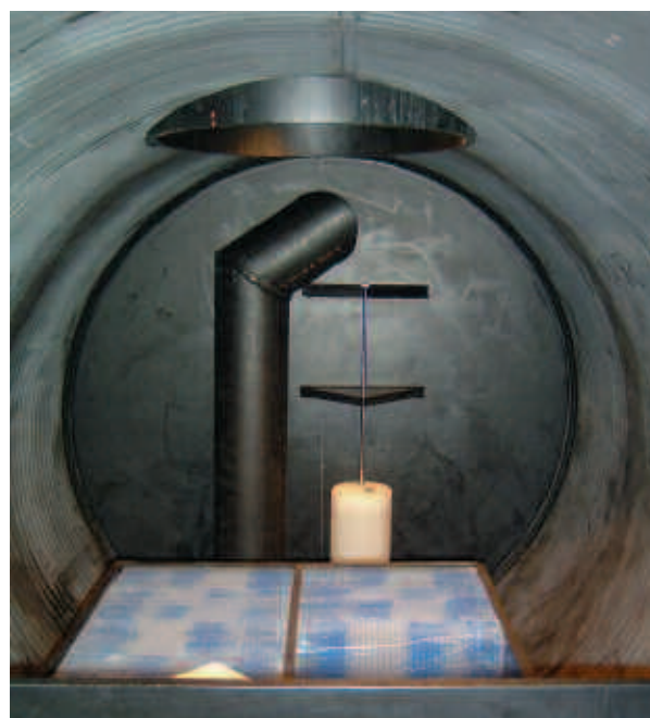
Vista interior del compartimento separador: Célula de coalescencia + obturador automático
