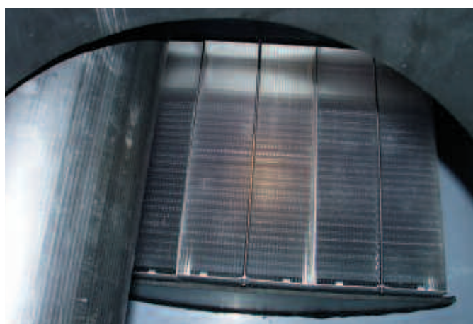
Célula coalescente : expulsión de hidrocarburos < 5 mg/l
