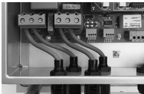
(Fig.) Conexión del generador fotovoltaico a través de conector de enchufe Tyco Solarlok
