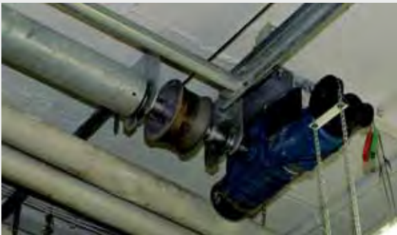
Eje con motor de ataque directo IP 65, eje montado detrás (sin muelle de torsión)
