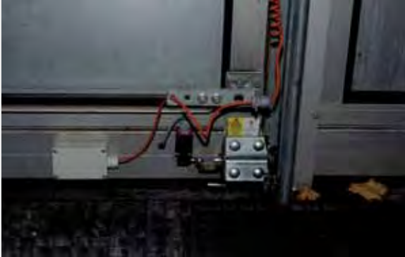
Herraje de la esquina, material acero inoxidable con caja de empalme tipo IP 65
