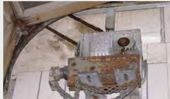
Eje con muelle de torsión y motor de cadena montado delante
