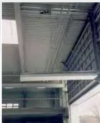
Pilar completamente retirado, facilitando la máxima apertura
