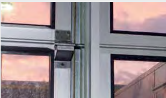
Bisagras, ángulos de rodamiento y soportes de rodamiento de acero inoxidable
