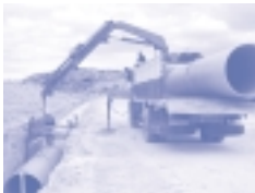
Fig. 1 - Descarga de tubos
