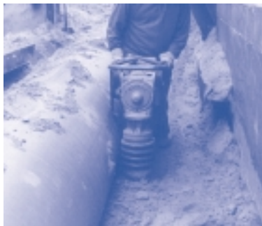
Fig. 20 - Compactación del relleno en los laterales
