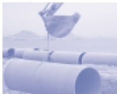
Fig. 15 - Utilización de eslingas en la unión con pala mecánica
