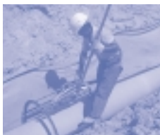
Fig. 14 - Unión de tubos mediante tráctel
