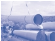
Fig. 2 - Descarga de tubos
