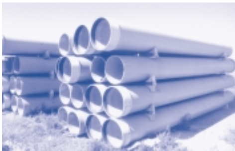
Fig. 3 - Apilado de tubos en obra
