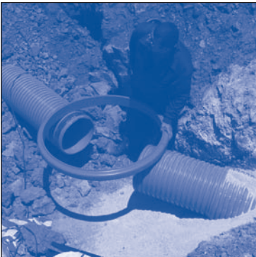
3 Se corta un aro (corrugada) del cuerpo del pozo, y se sitúa sobre los extremos del colector.
