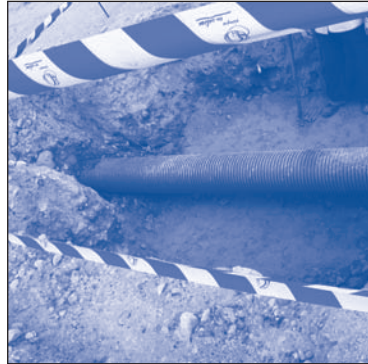
2 Tuberías ya instaladas en línea.
