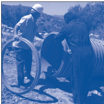
5 Se coloca el aro marcado en la base del pozo, teniendo en cuenta cual va a ser su posición en la zanja, y se marca la posición de los ejes de los entronques.
