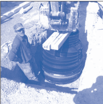
8 Rematarlo con el cono de reducción.
