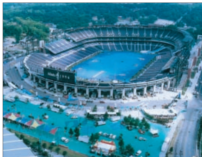
Estadio Olímpico de Atlanta en Estados Unidos. Más de 2000 válvulas Maxi-Vent y Mini-Vent STUDOR ® se han colocado en este singular edificio.
