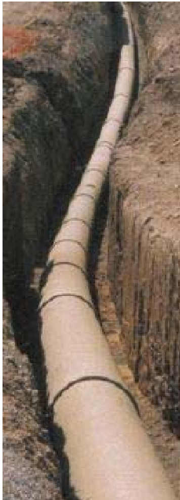
Fig.10 Tubería de poliéster centrifugado en zanja. Obsérvese cómo se aprovecha el ángulo de desviación que permite la unión de los tubos para conseguir una curvatura en el trazado lo que hace innecesario tener que utilizar otros accesorios.
