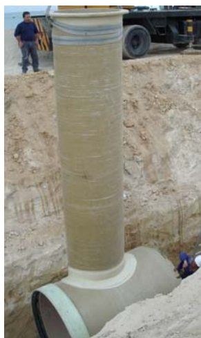
Fig. 6 Piezas especiales realizadas en poliéster reforzado con fibra de vidrio.
