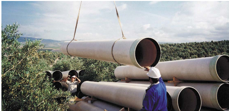
Fig. 3 Tubería descargándose en obra, en primer término puede observarse el manguito de unión.
