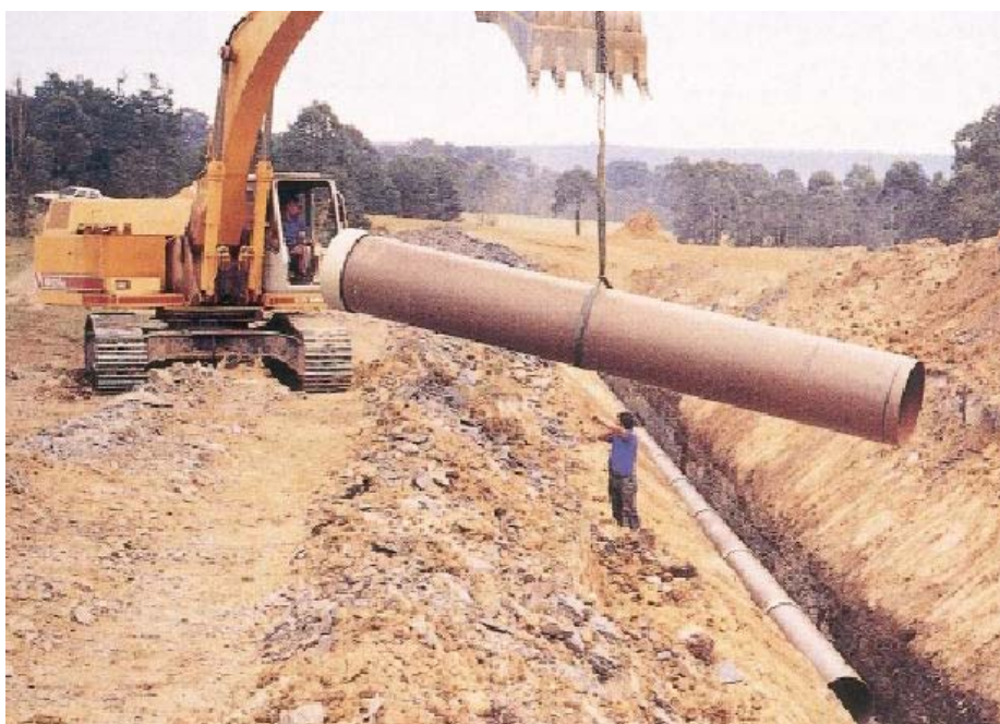
Fig.8 Utilización de eslingas en el montaje con pala mecánica. Dos operarios son suficientes para este trabajo. La rapidez en el montaje permite un rápido avance de la obra.
