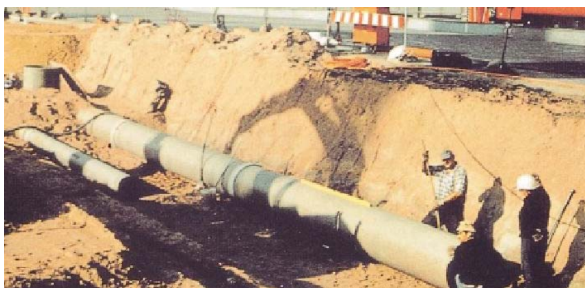
Fig.7 Instalación en obra previa al relleno del apoyo.
