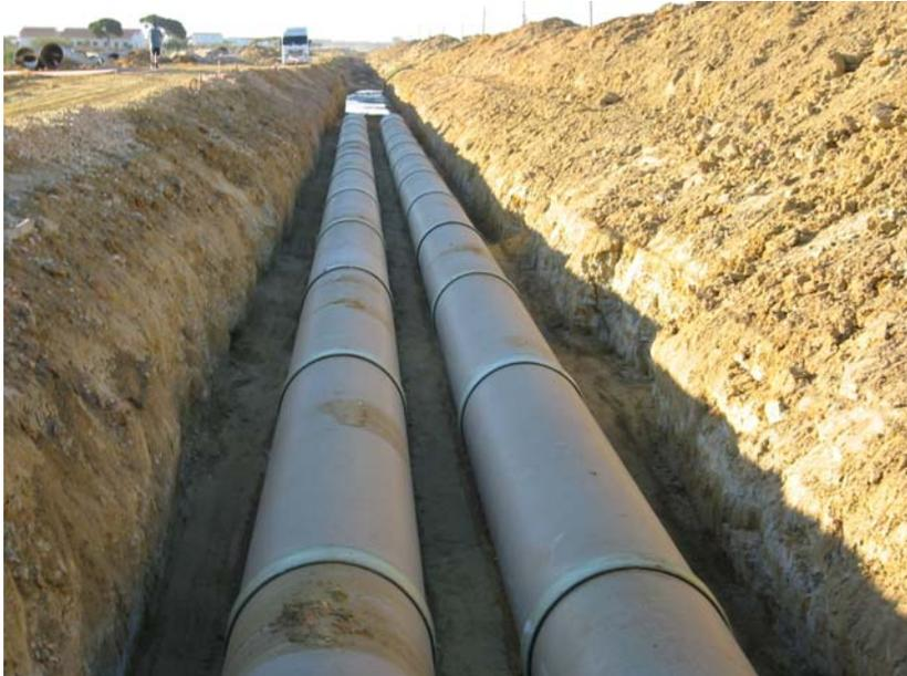
4. Tubos perfectamente alineados en el interior de la zanja a falta de los rellenos de apoyo y zanja.
