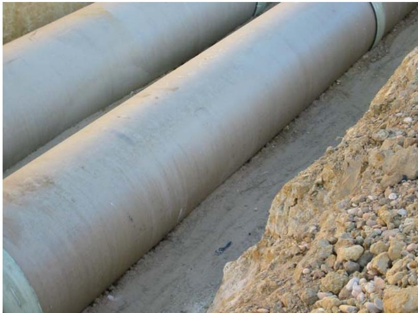
5. La cama sobre la que apoya la tubería está uniformemente extendida a lo largo de la base de los tubos.
