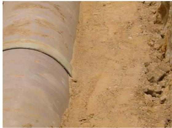
7. Mediante la compactación del relleno se genera una presión lateral de las tierras sobre la tubería que produce un reparto de cargas y un control de la deformación del tubo. Durante la ejecución se cuidó especialmente que no quedaran espacios sin rellenar debajo del tubo y de los manguitos de unión.
