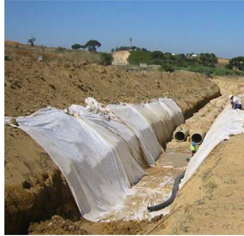
9. Dos instantáneas del montaje de tuberías con geotextil en zanja. En la parte inferior derecha de la zanja puede observarse el tubo para el drenaje.
