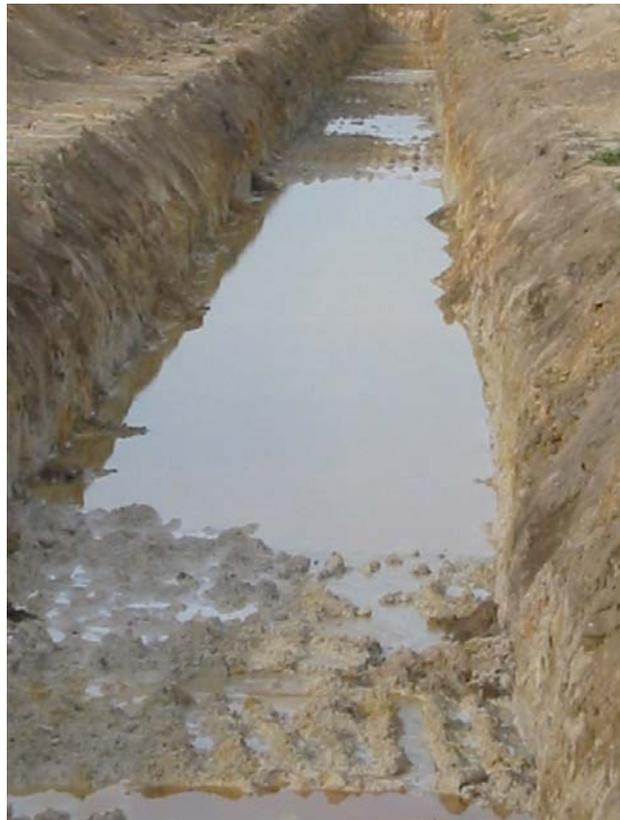
8. Durante la excavación hubo afloramientos de venas de agua. El agua desestabiliza la zanja produciendo migraciones del terreno sobre el que apoya los tubos. Se solucionó con la instalación de un geotextil y un tubo de drenaje.
