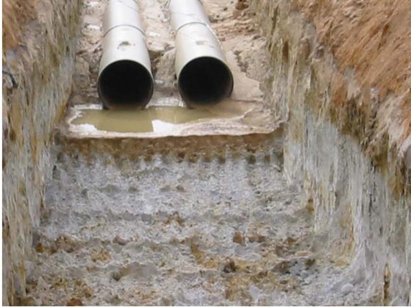
3. Obsérvese la anchura de zanja, el espaciado entre tubos para permitir la compactación del relleno y la uniformidad de la cama sobre la que apoyan los tubos.
