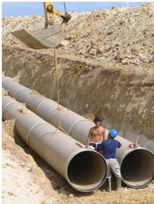
2. Instalación de tubería PRFV- DN 1000 en doble conducción: Utilización de la cuchara de la excavadora para el montaje de la tubería. La limpieza del interior de los manguitos y del extremo hembra del tubo y la aplicación de jabón lubricante garantizaron un perfecto acople de los tubos.
