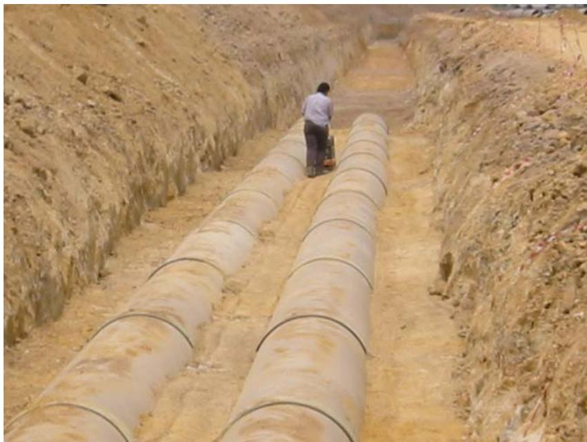
6. Una vez rellenado el apoyo de los tubos se hizo una compactación al 95% Próctor con verificación del grado. En la foto se observa al operario compactando en el espacio entre tubos con un pisón vibrador.
