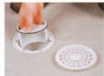
Sacar el registro con junta y limpiar los restos.
