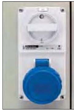
Tomas de corriente de 2 P+T (azul) y 3 P+T, 3 P+N+T (rojo).
