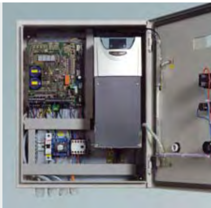
Apertura automática de la puerta mediante USV. Deja libre el camino en caso de fallo de la corriente.
