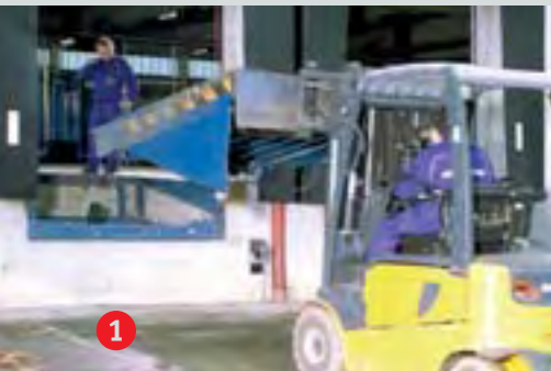
Desmontar la antigua rampa niveladora
