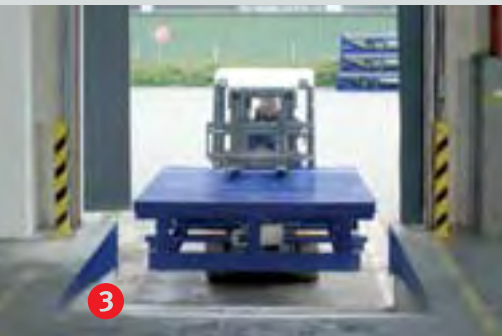
Insertar la nueva rampa niveladora
