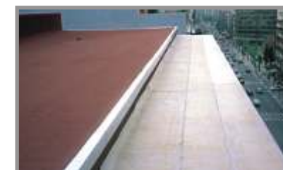
Detalles de cubierta de edificio de la Administración Pública, Barcelona. No transitable.
