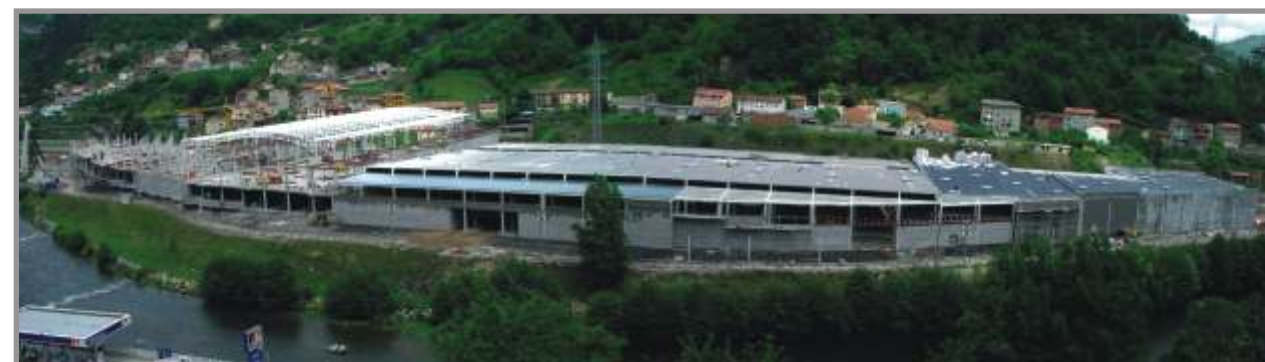
Detalles de cubierta de centro comercial y de ocio, Asturias.
