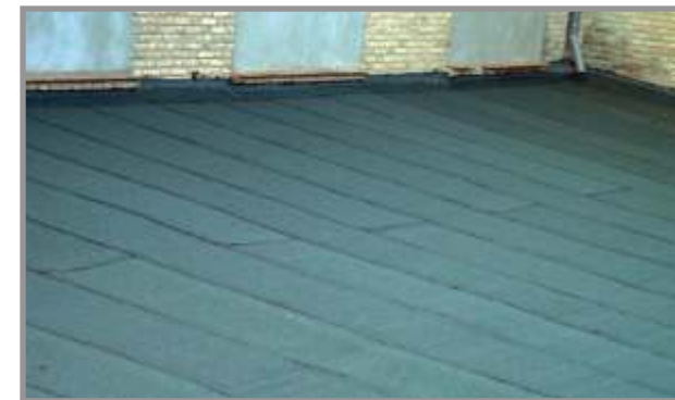
Detalles de cubierta finalizada.
