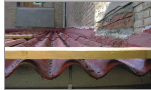
Detalles de inicio de la aplicación en la cubierta.
