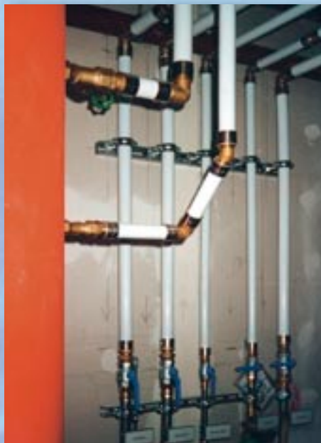
PRINETO – instalación en el tabique.
