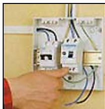
**Conexión de la derivación individual y toma tierra ITC-BT-15**
